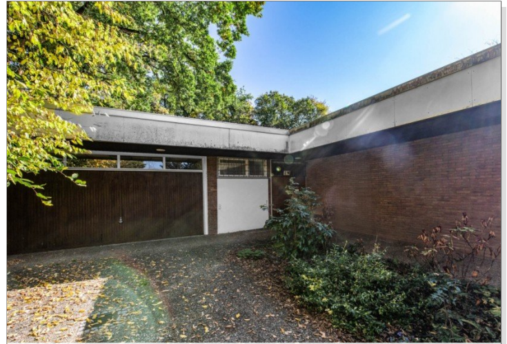
Hausansicht mit Garage
