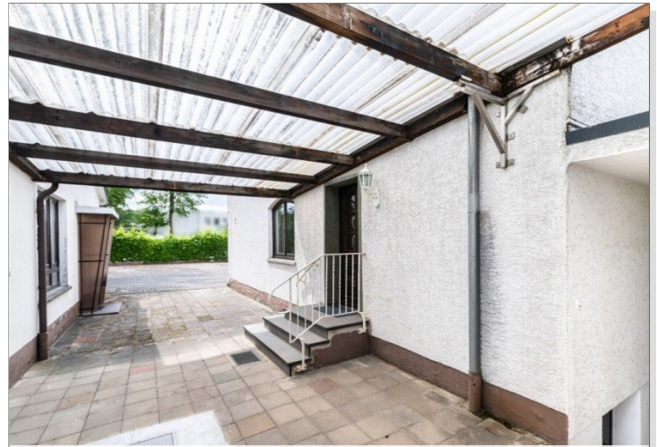
Überdachung zwischen Werkshalle und Wohnhaus
