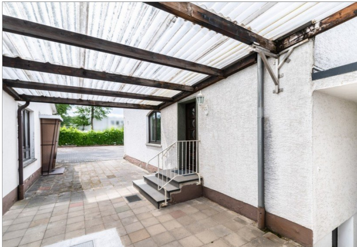
Überdachung zwischen Werkshalle und Wohnhaus
