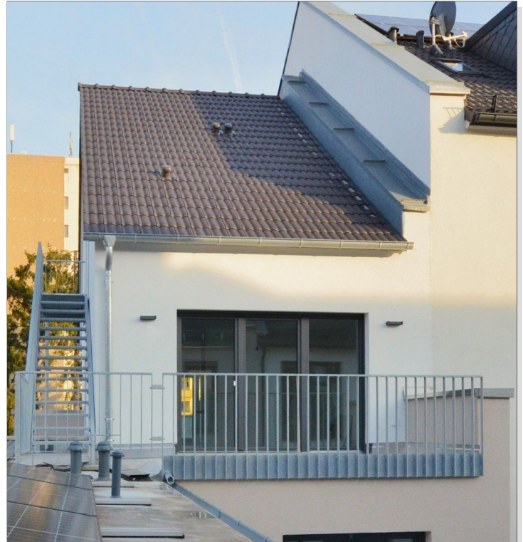
Außenansicht 2.OG Küchenbereich & West-Terrasse
