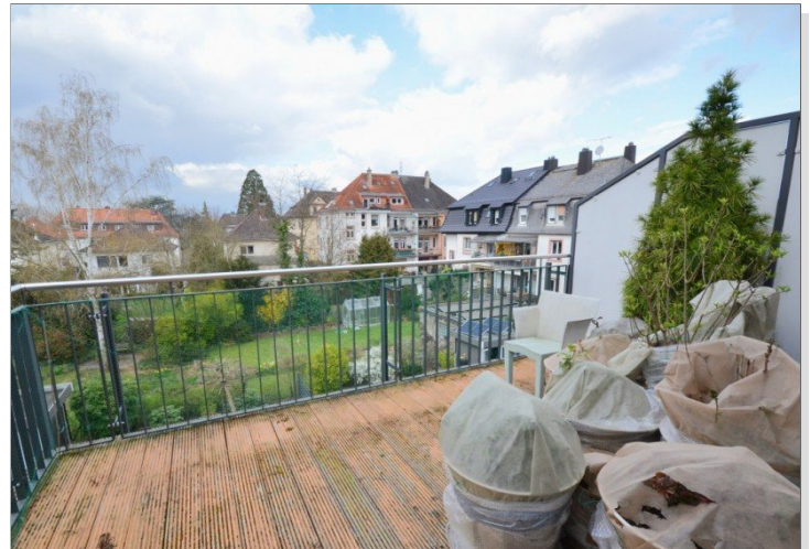
Balkon (Westausrichtung - Bodenbelag wird im Frühjahr erneuert)
