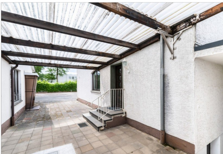
Überdachung zwischen Werkshalle und Wohnhaus
